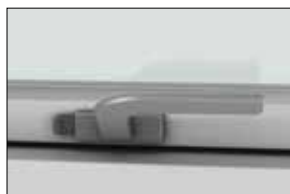
Paskvilgreb med børnesikring. Monteret med børnesikringsknap.
