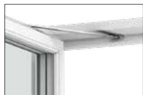
Frikationsbremse. Til sidehængte vinduer mod tillæg. Kan kun vælges i kombination med anverfer.
